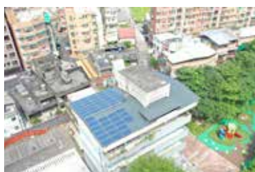
▲和風樓防水隔熱改善
