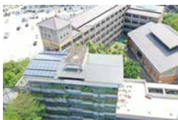
▲麗日樓防水隔熱改善
